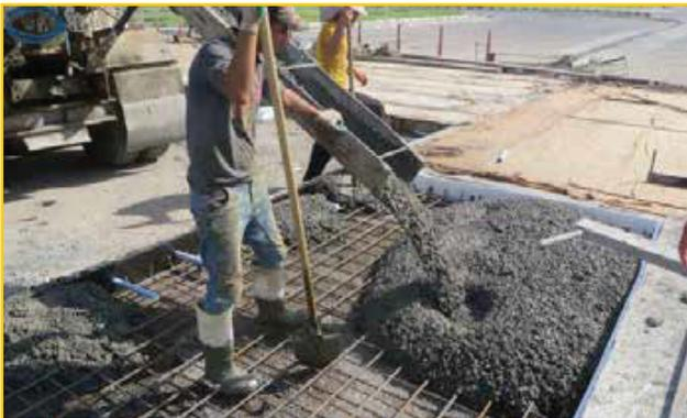
Vand Plast R34 روان کننده و دیر گیر کننده بسیار موثر ، مخصوص تهیه بتن مرغوب مخصوصاً در شرایط جوی مناطق جنوب ایران می باشد. Vand Plast R34 با خاصیت دیرگیر کنندگی ضمن افزایش روانی بتن در هوای گرم فرصت حمل و استقرار بتن قبل از گیرش را مهیا می نماید.
